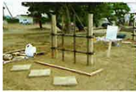
造園工事作業の作品例
