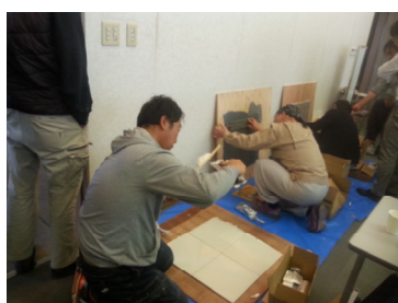
平成 28 「タイル張り職種」
